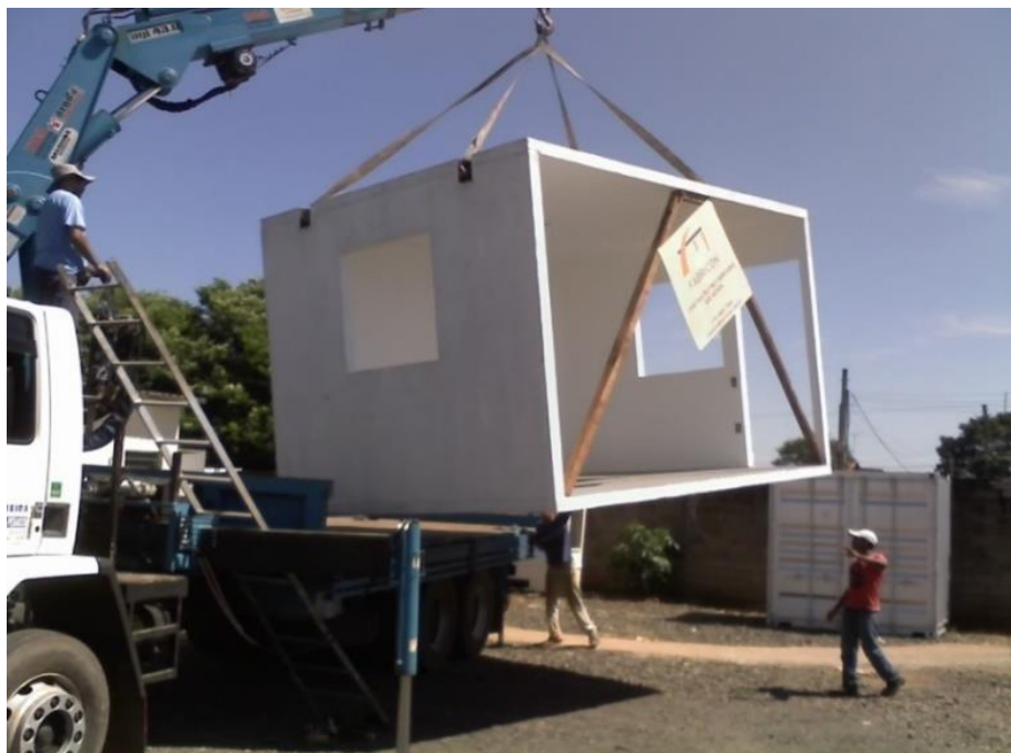
Figura 2 – cápsula em argamassa armada para utilização como compartimento de permanência. Dimensões aproximadas: c=4,00m, l=2,70m, h=2,50m internos. Espessura 12cm compreendendo 2 cm em cada face externa e miolo de eps de 8cm. Peso = 2,9 toneladas. Fonte: peça e imagem realizada pelo autor.
