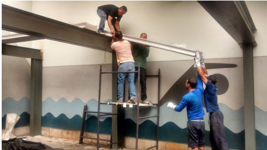
Figura 1: Montagem de elementos modulares em argamassa armada para fechamento de laje de piso. Sobrecarga = 500 kg. Dimensões aproximadas: c=2,70\text{m} , l=50\text{ cm} , esp.= alma de 10cm, mesa de 2cm perfazendo o total de 12cm. Fonte: peça e imagem realizada pelo autor.
