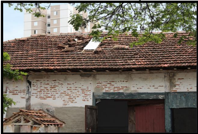
Reparo no telhado
