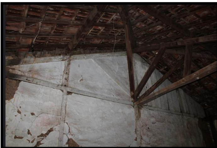
Reparo na estrutura
