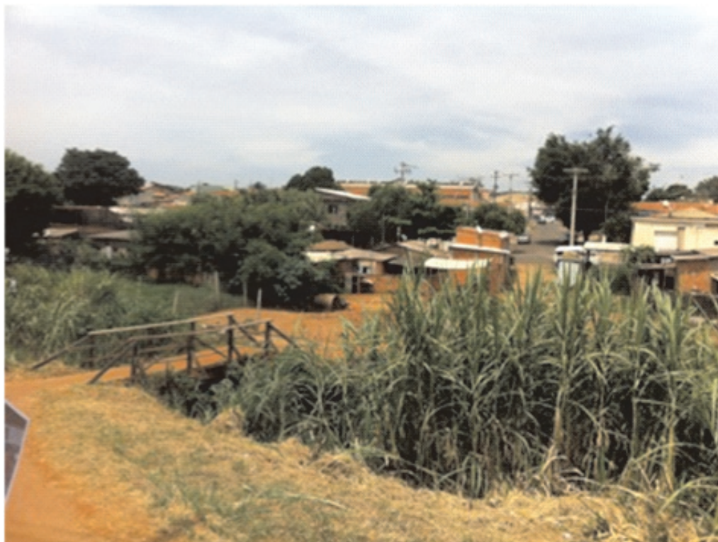
Figura 5 - Foto de uma das visitas de campo feita pela equipe do PET. Transposição de pedestres sobre o córrego da Lagoa
